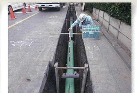
▲ガス本支管工事(中圧)
