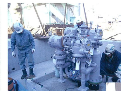
▲ガスガバナー設置工事
