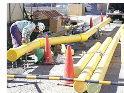
▲ガス本支管工事(低圧)
