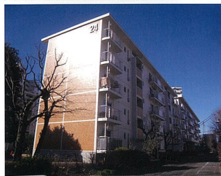
▲既存集合住宅の改修工事
