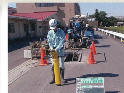
▲グルンドドリル工法(推進工事)
