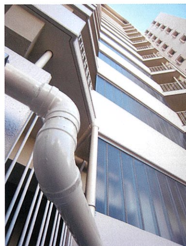
▲既存集合住宅の改修工事 (屋外配管80A)
